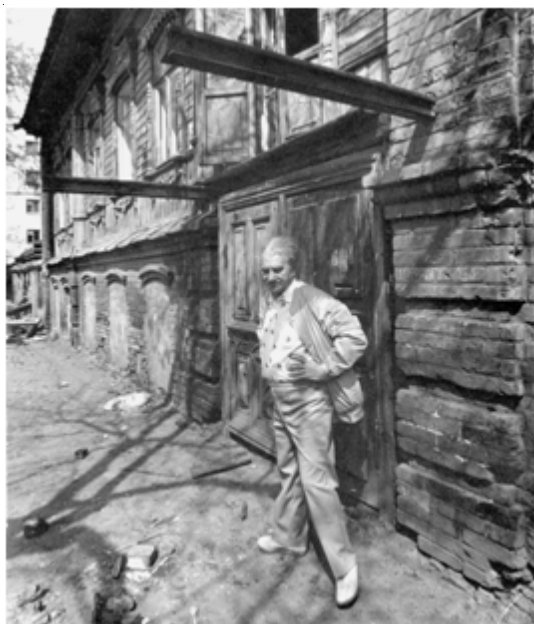
Рис.10. Рельсы, сделанные заводом Демидова в Нижнем Тагиле и заводом Белосельского - Белозерского в Катав-Ивановске на доме по улице Томина, 64 в г. Кургане
