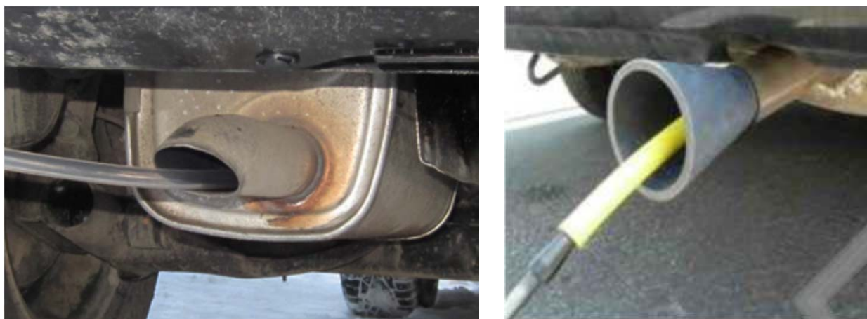
Рисунок 6.7 – Подключение генератора дыма к системе выпуска отработавших газов двигателя
