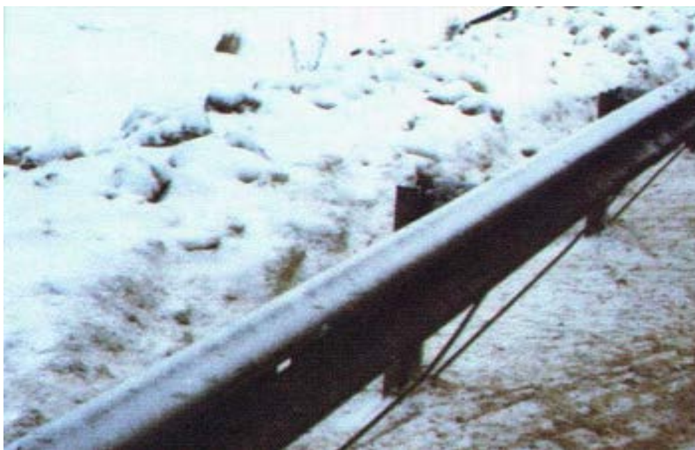
Рисунок 2.4 – Наличие снега на обочинах и около ограждений (снег с обочин и около ограждений убирается или вручную, или с использованием специализированного оборудования)
