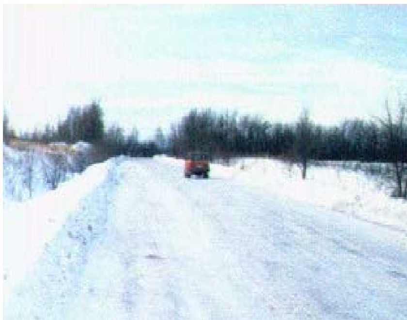
Рисунок 2.2 – Наличие снега на проезжей части, тротуарах и обочинах ( нарушение требований ГОСТ Р 50597-93 раздел 3 )
