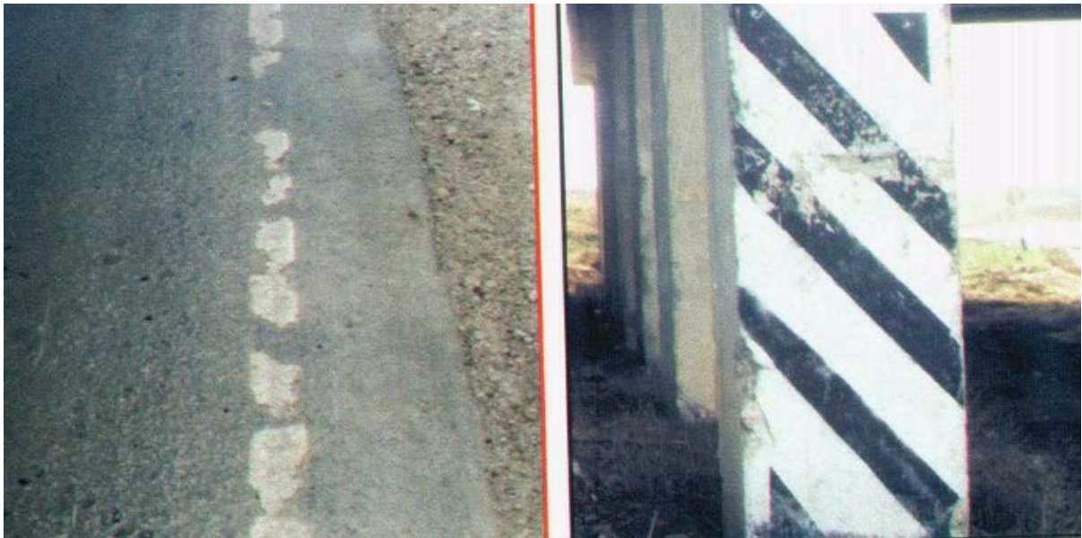
Рисунок 1.6.2 – Износ вертикальной и горизонтальной дорожной разметки (необходимо восстановление, данный вид работ входит в содержание дороги)
