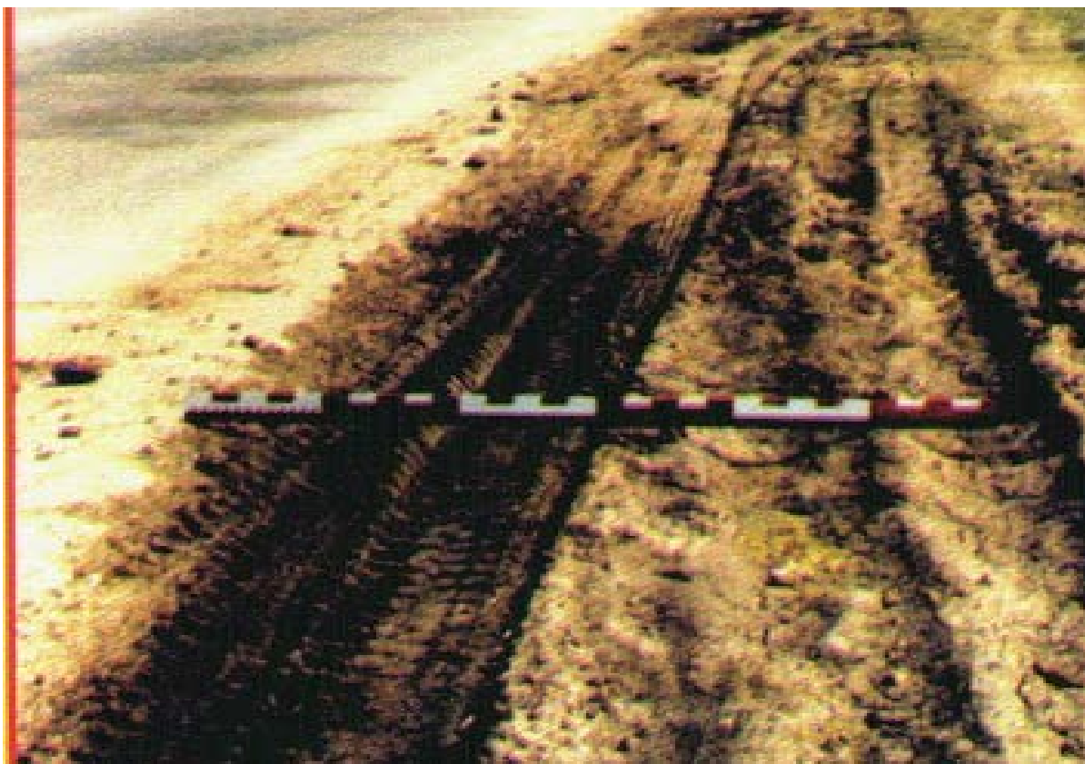
Рисунок 1.5 – Дефекты земляного полотна (необходима досыпка и укрепление обочин, при недостатке грунта для восстановления геометрических параметров обочины, работа выполняется по отдельной смете и не входит в содержание дороги)
