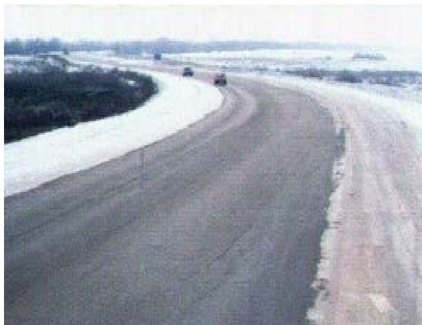
Рисунок 2.1 – Наличие снега на проезжей части, тротуарах и обочинах (нарушение требований ГОСТ Р 50597-93 раздел 3)
