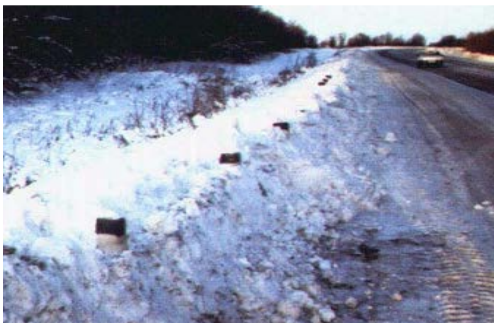
Рисунок 2.3 – Наличие снега на обочинах и около ограждений является нарушением
