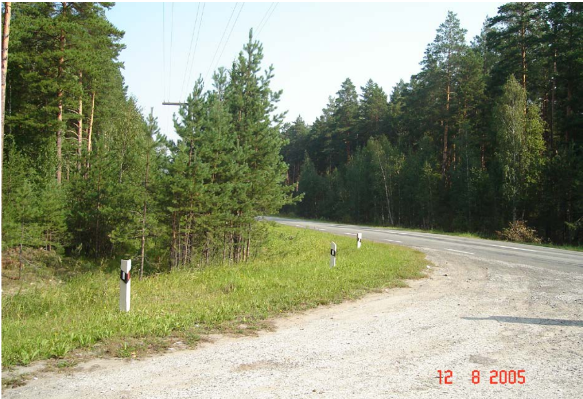
Рисунок 1.8 – Автомобильная дорога «Курган – Тюмень» (необходимо вырубить кустарник на пересечении дорог, данный вид работ входит в содержание дороги)
