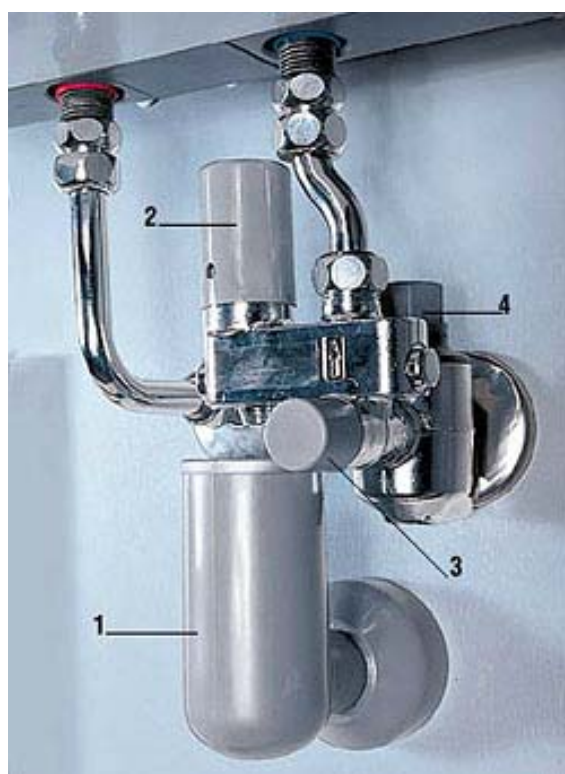
Рис. 1. Группа безопасности для накопительных электронагревателей:
